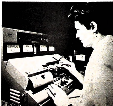
Bild 8. Prüfeinrichtung für Stereo-Tonköpfe
